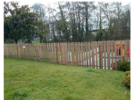
Pose d'une palissade à la crèche de Kerhuel
