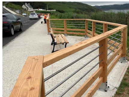
Pose de garde-corps pour la ville de Lannion sur le site de Beg Leguer
